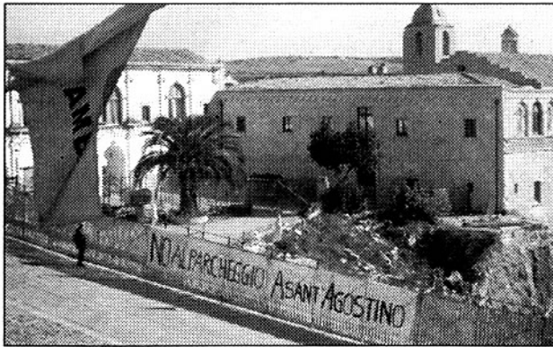
I lavori per il parcheggio di Sant'Agostino
